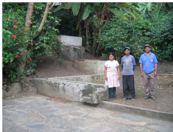
Photos : une installation de traitement post-récolte par voie humide du café (canal de correteo) d'une exploitation certifiée « bio » d'un producteur de COCLA
