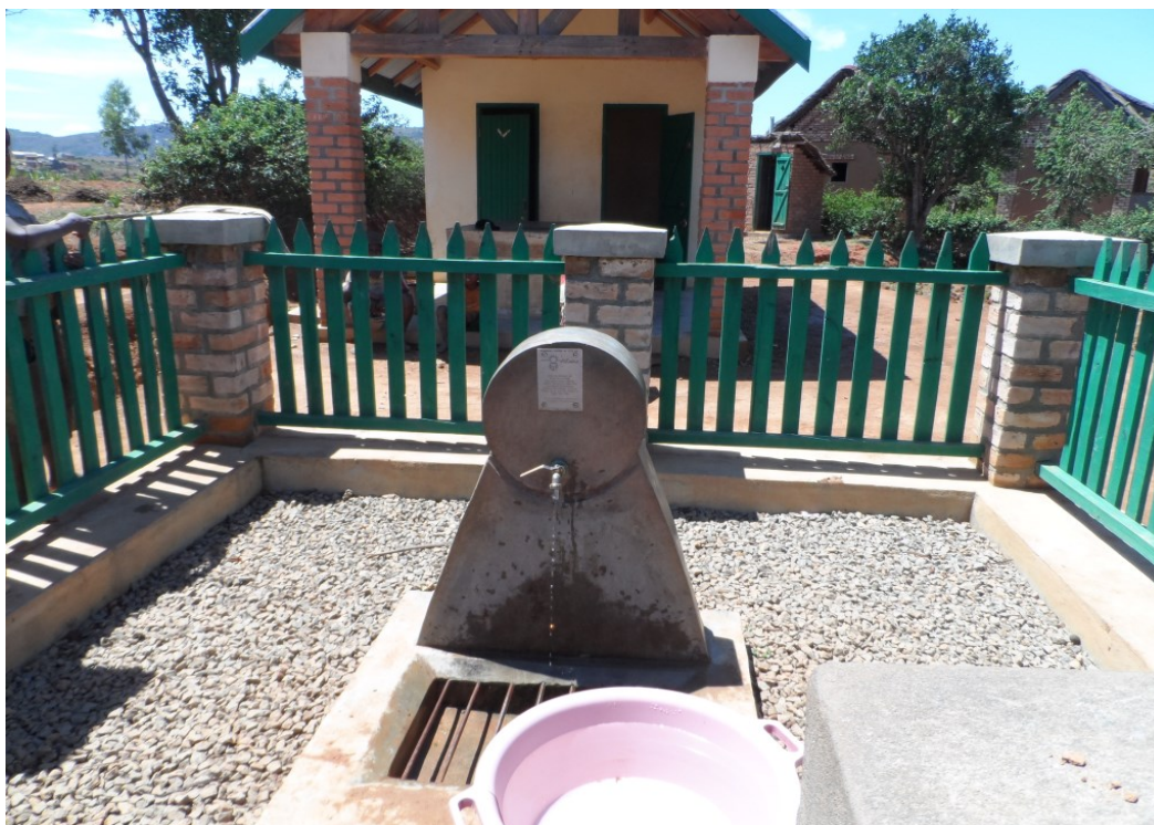
Fig.5 Bornes fontaines, blocs sanitaires et latrines (village Akarandoha/Fianarantsoa)
