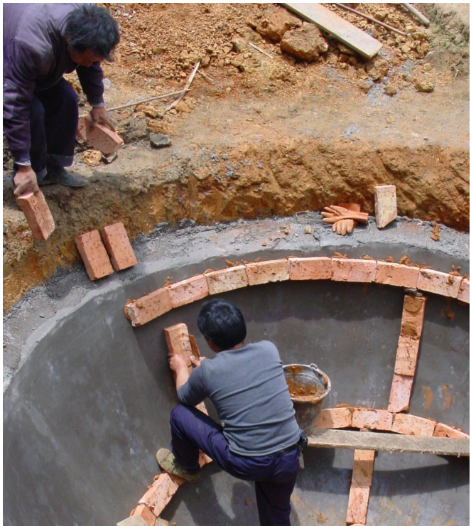
Construction d'un biodigesteur—ID
