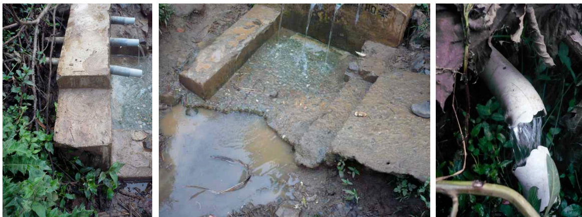
Figure 10 : Source réhabilitée – Nyambohondo (2008)
